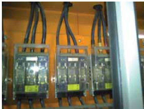
Die Inspektion der Elektroinstallation enthüllt elektrische Anomalien – hier durch einen Blick auf die Kabel, die zu den Sicherungen im Plexiglasgehäuse führen. Dank MeterLink werden die mit der Stromzange ausgelesenen Werte im Wärmebild angezeigt.
